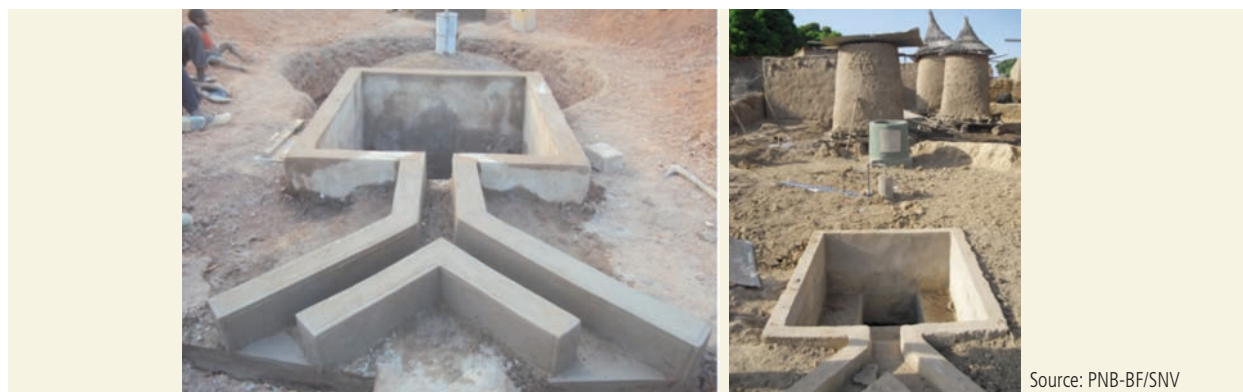
Figure 4. Biodigesteur à dôme fixe en construction
