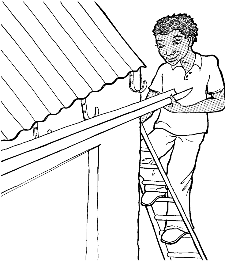
Figure 4 : Installation d'un système de gouttières
