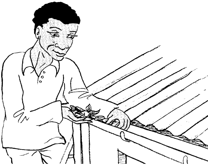
Figure 29 : Retirez régulièrement les débris des gouttières
